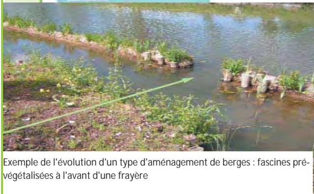
Exemple de l'évolution d'un type d'aménagement de berges : fascines pré-végétalisées à l'avant d'une frayère
