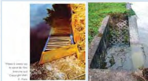
**Retour expérience 1 :** Installation de système pour la remontée de la faune sur les berges du Canal de la Marne au Rhin
