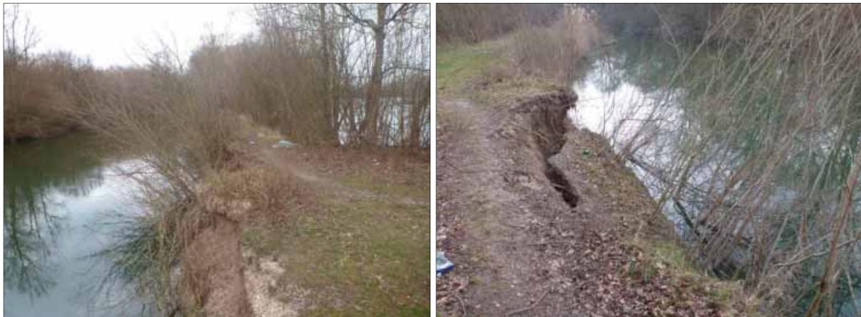
Erosion de berge localisée sur le tronçon VS4 de la Vieille Seine au niveau de la digue séparant le cours d'eau et un casier SEDA.
